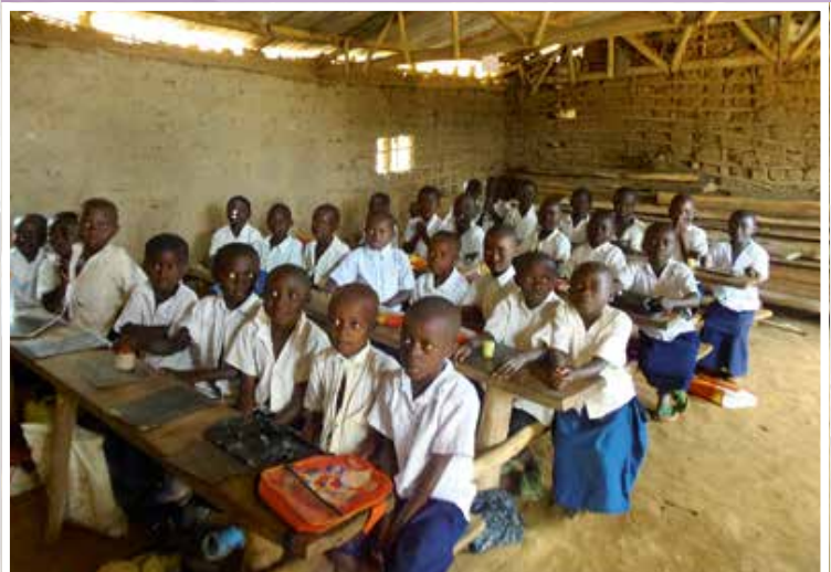
Les écoles et les salles de classe nécessitent de temps en temps des rénovations
